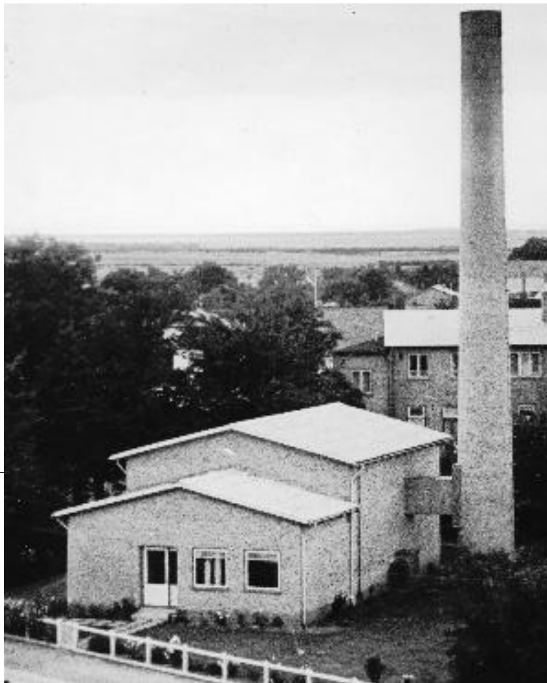
Fjernvarmeværket på Skolestien 1957.
