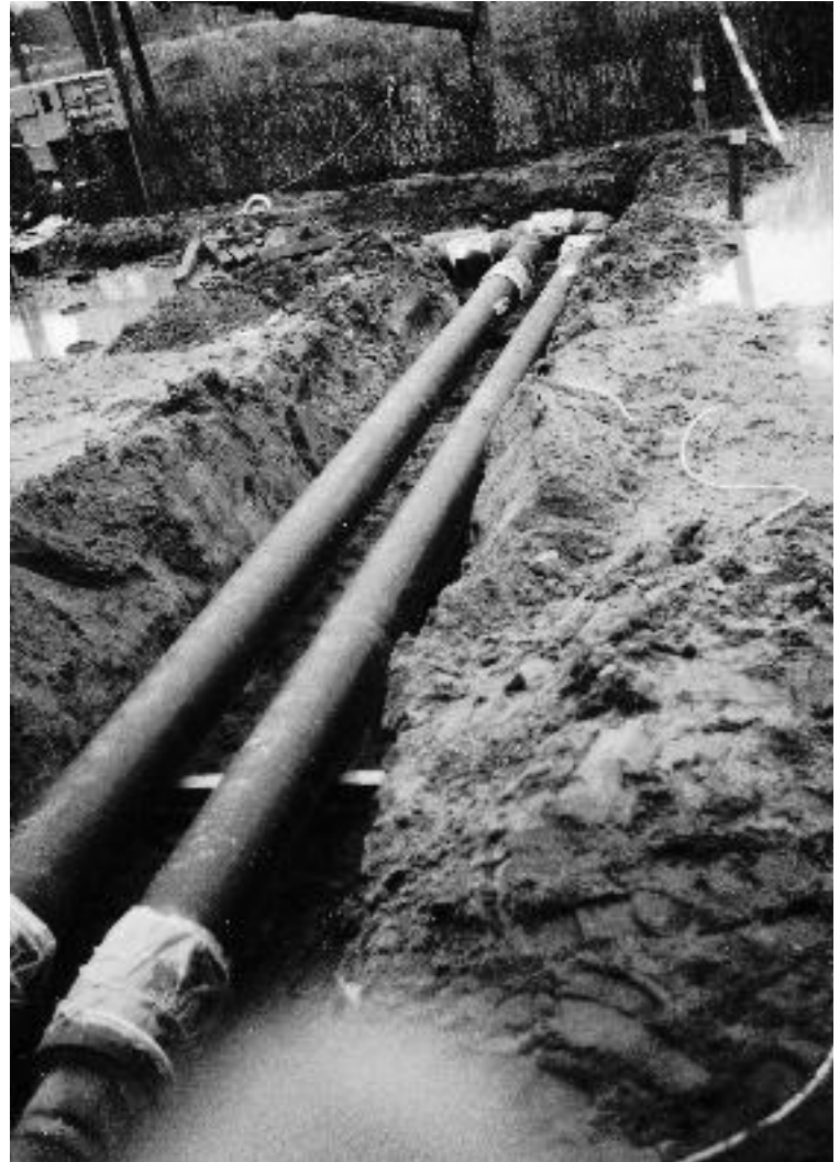
Forbindelsesrørene lægges mellem det nye kraftvarmeværk på Læssevej og pumpestationen på Skolestien 1991.
