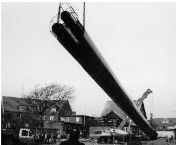
Den nye skorsten på Skolestien rejses 1984.
