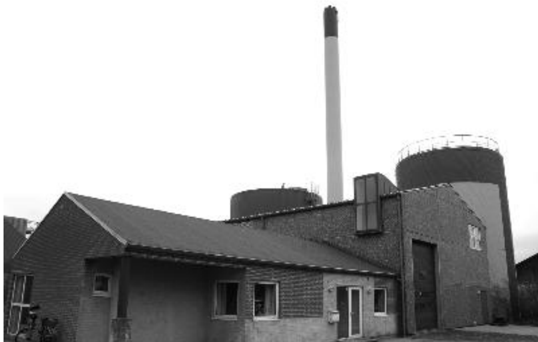
Skærbæk Fjernvarmeværk 2006. Foto: Lars Detlef.
